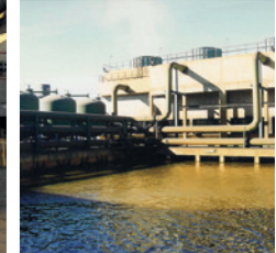
Station de traitement des eaux
