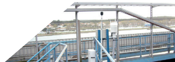
sur notre site (au niveau du parc à ferrailles)
